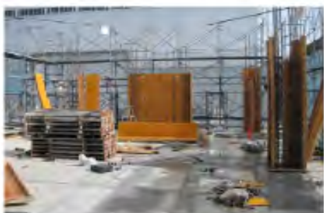
(d) Preparation for forms
