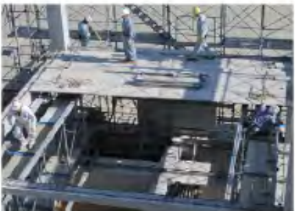
(d) Half precast concrete floor panel
