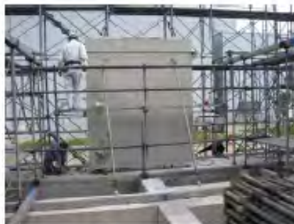
(d) Erection of wall
