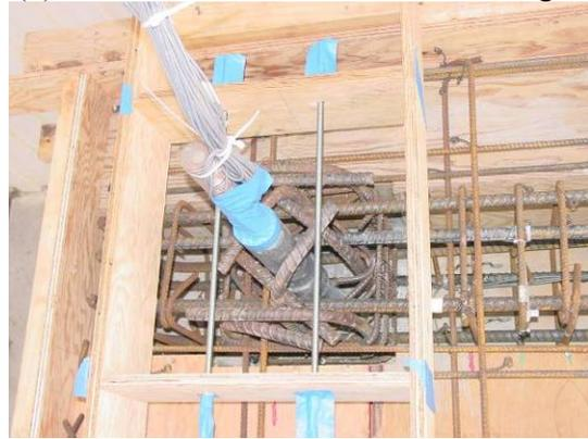
(d) Top view of concentric post-tensioning rod
