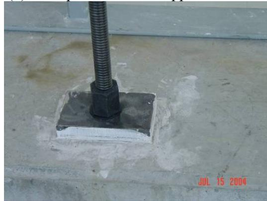
(d) High-strength post-tensioning rod
