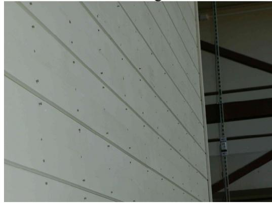
(d) Detail of shear wall with shiplap siding
